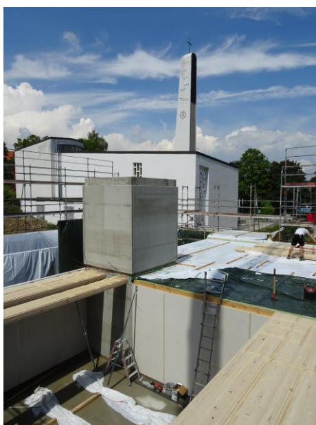
Einblick in die Holzständerbauweise
